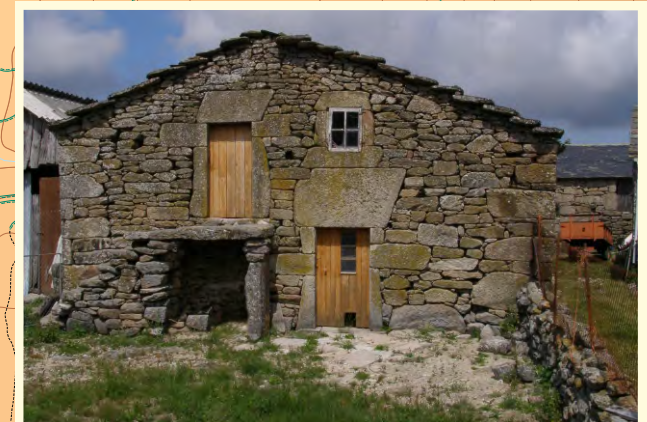
Na planta baixa da casa estaba a corte, con diminutas bufardas para ventilación. Á vivenda accédese pola escaleira exterior precedida dun pequeno descanso a modo de solaina. A cuberta é un sinxelo teitado, de grandes lousas, sen cheminea.
